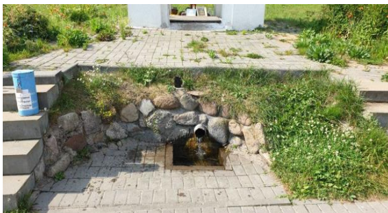
Фото 4. Каптаж родника с металлическим коробом
