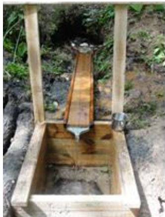
Фото 3. Каптаж родника с коробом из террасной доски
